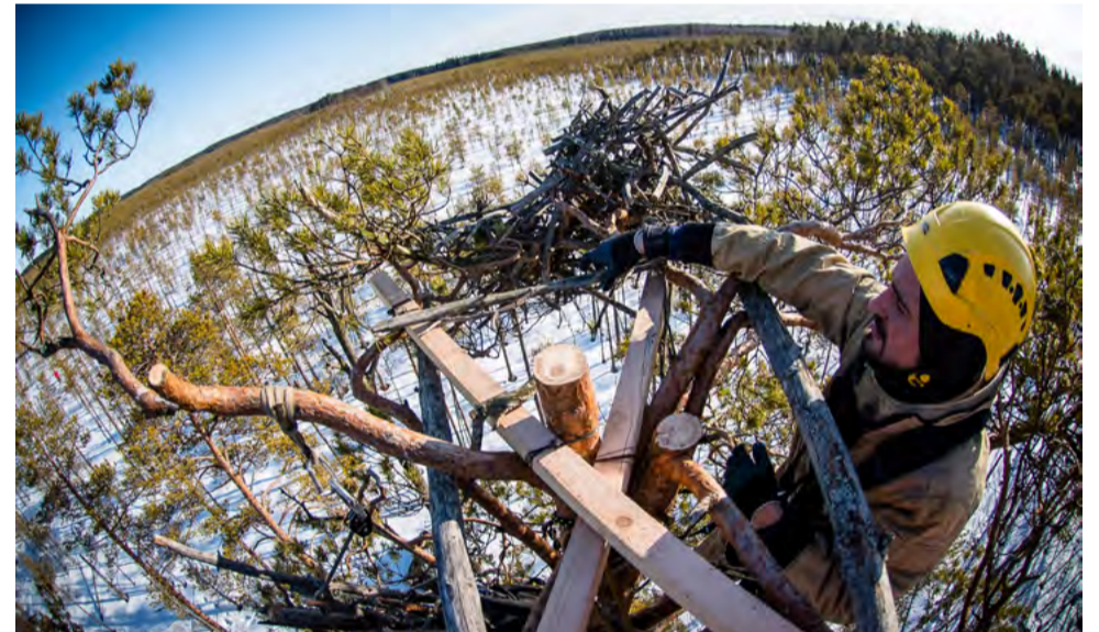
На месте разрушившегося гнезда строим новое. Сперва к ветвям и стволу крепятся прочные несущие детали конструкции. Затем сверху выкладывается подушка из сухих веток
